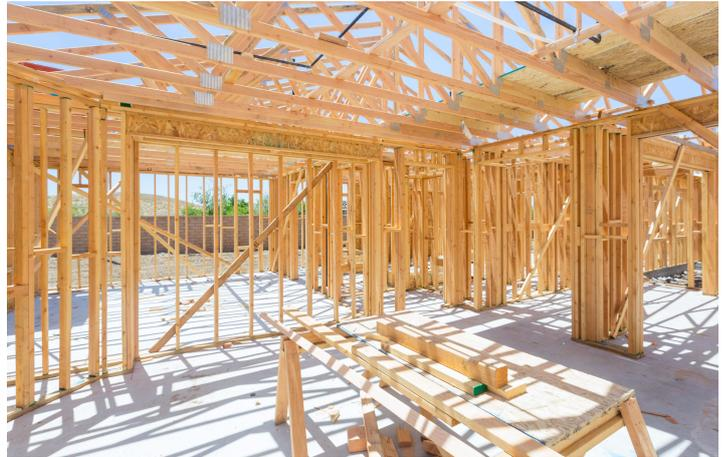
A ese entramado se le deberá aplicar una o dos placas de OLB construcción (una en cada cara) de acuerdo con su rol estructural en la vivienda y como lo indica el procedimiento y memoria de cálculo. Las placas de OLB construcción se fijarán a la estructura de madera con clavos helicoidales.
